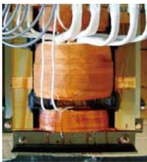
正常な安定器の状態
